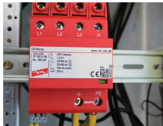
Bild 4 Schutz der AC-Stromversorgung einer Basisstation mit DEHNvap CSP 3P 100 S FM
